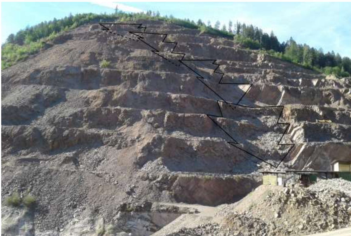
Fig 13: panoramica del fronte cava di Monte Gorsa con evidenziate le "scatole cinematiche" che individuano il fenomeno gravitativo
