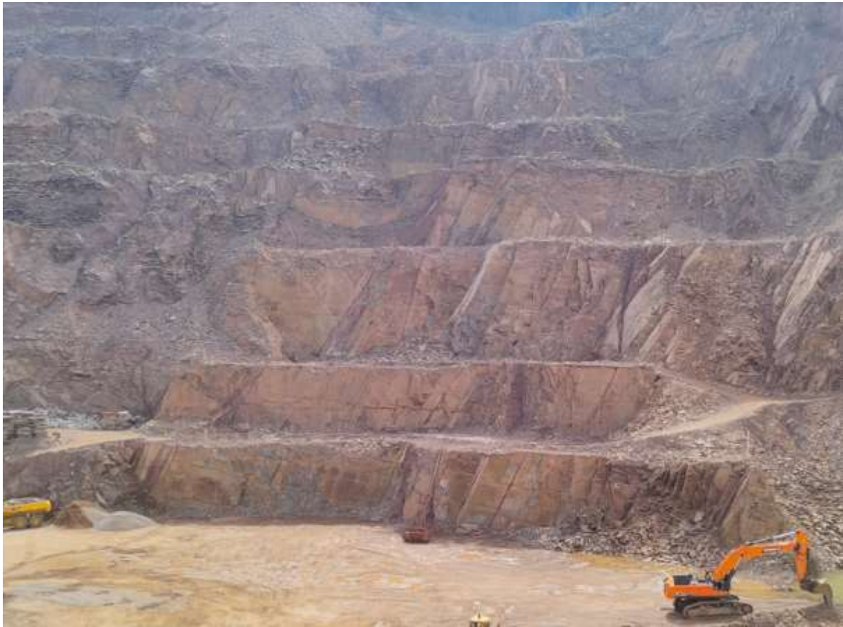
Foto.2 particolare di alcuni gradoni presenti nell'area dove di nota l'evidente fratturazione dell'ammasso definita da un numero limitato di famiglie principali, si notano inoltre zone ove l'ammasso roccioso risulta scompaginato a causa della coltivazione che su questi fronti avviene secondo pariana rovescia in concomitanza alla presenza di faglie a grande persistenza associate alle famiglie KK2 e KK3 (con i lassi KK1 orientati perpendicolarmente al fronte di avanzamento ed immergenti circa nella stessa direzione)
