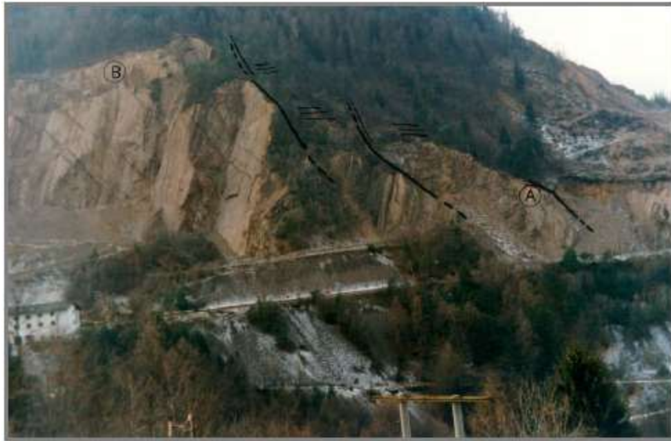
Fig.11: Frana Ronchi nord 1988 (foto 1992): i tre piani di scivolamento con le fessure di trazione
