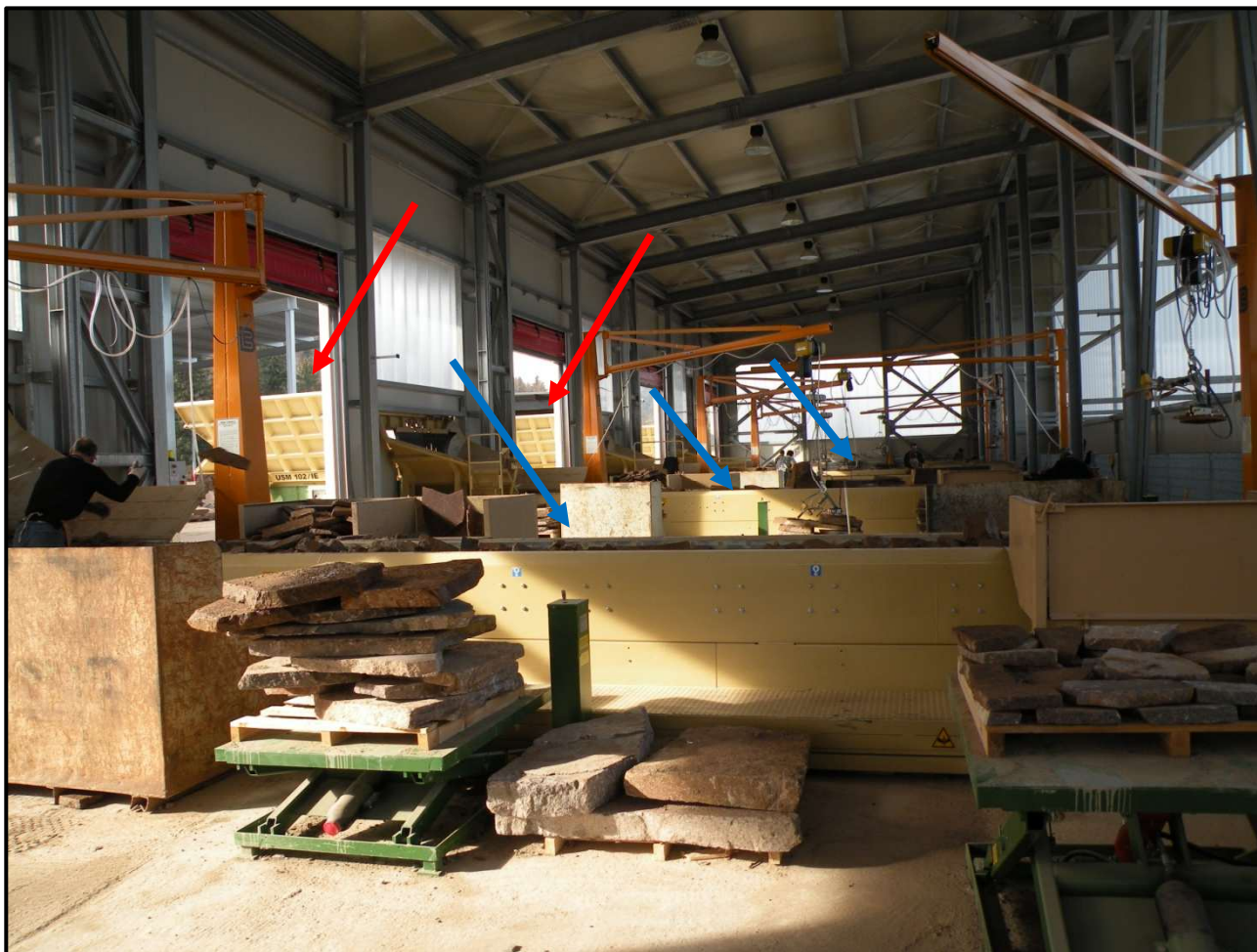
Figura 47: Esempio di banconi di cernita installati sul lotto n. 4 Santa Colomba
