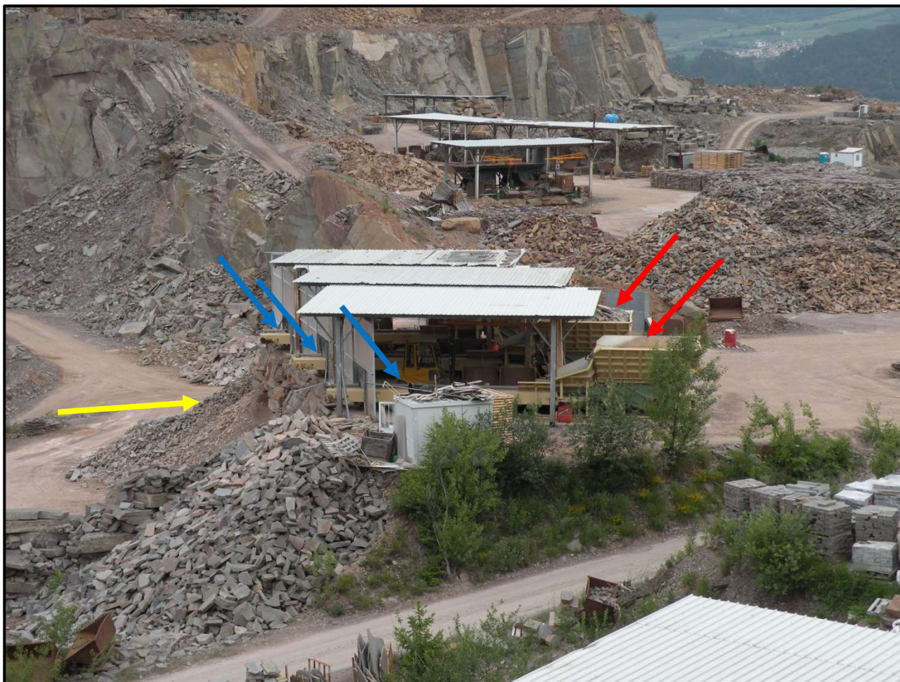
Figura 46: Esempio di banconi di cernita installati sul lotto n. 9 Monte Gaggio
