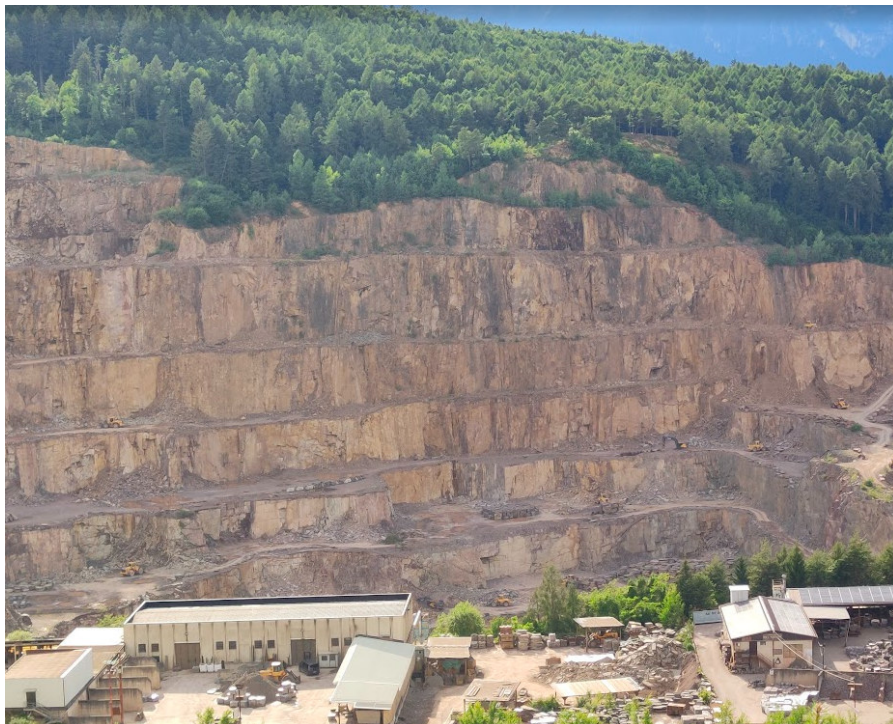
Panoramica del versante nell'area del macrolotto 2
