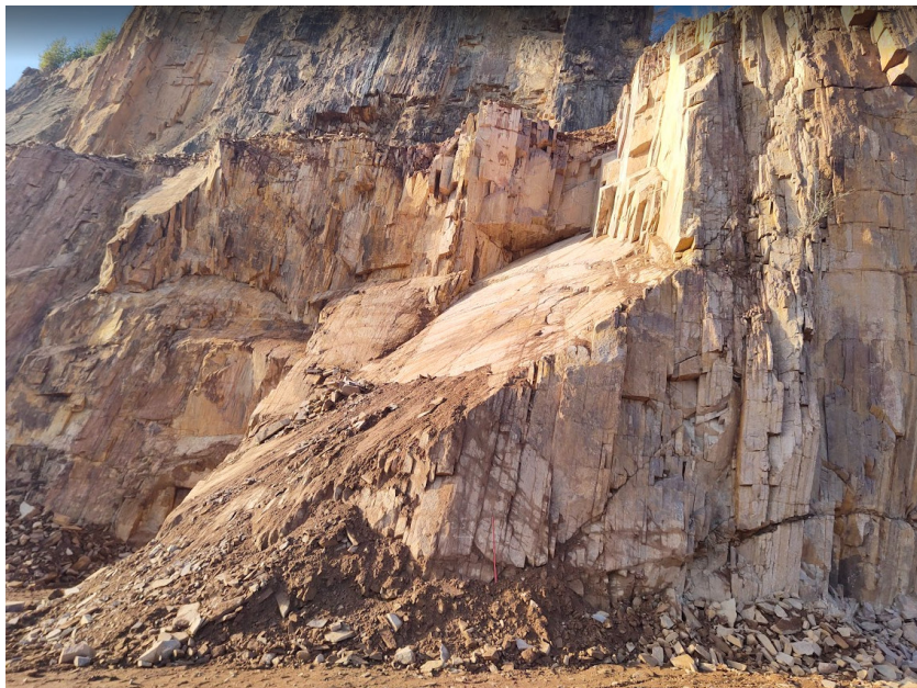
Evidente piano di discontinuità a franapoggio individuato dall'intersezione tra faglie con giacitura 107N45° ed i sistemi KK1 e KK2
