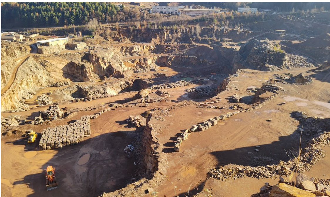
Area degli attuali ribassi in corrispondenza dei futuri macrolotti 1 e 2
