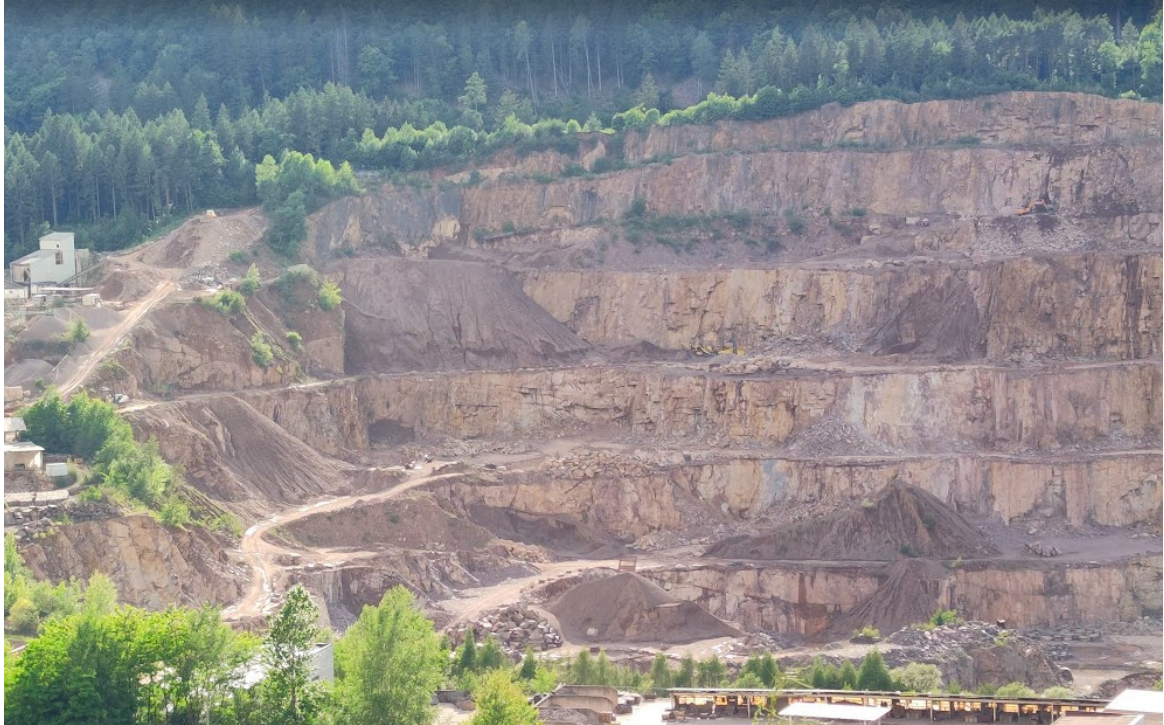
Panoramica del versante nell'area del macrolotto 1
