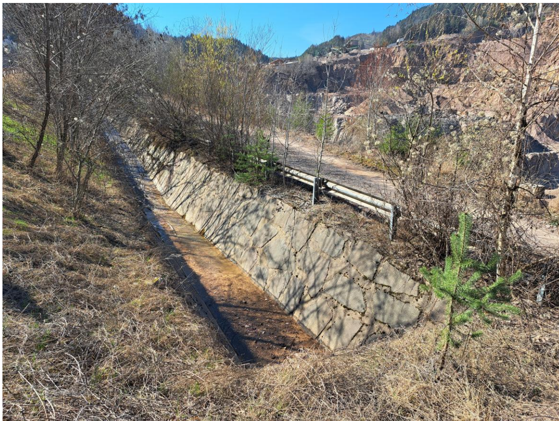
Figura 6: Alveo artificiale del Rio Segà a lato dell'area estrattiva (foto marzo 2026)
