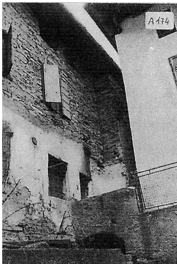
SCORCIO INTERNO CORTILE LATO SUD-EST
