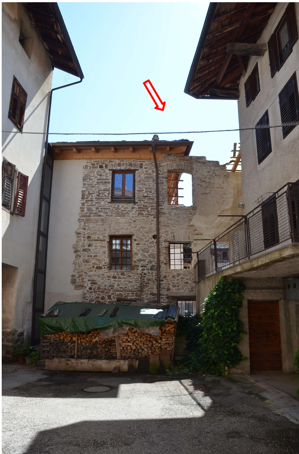
SCORCIO INTERNO CORTILE LATO SUD-EST DOPO LA PARZIALE DEMOLIZIONE
