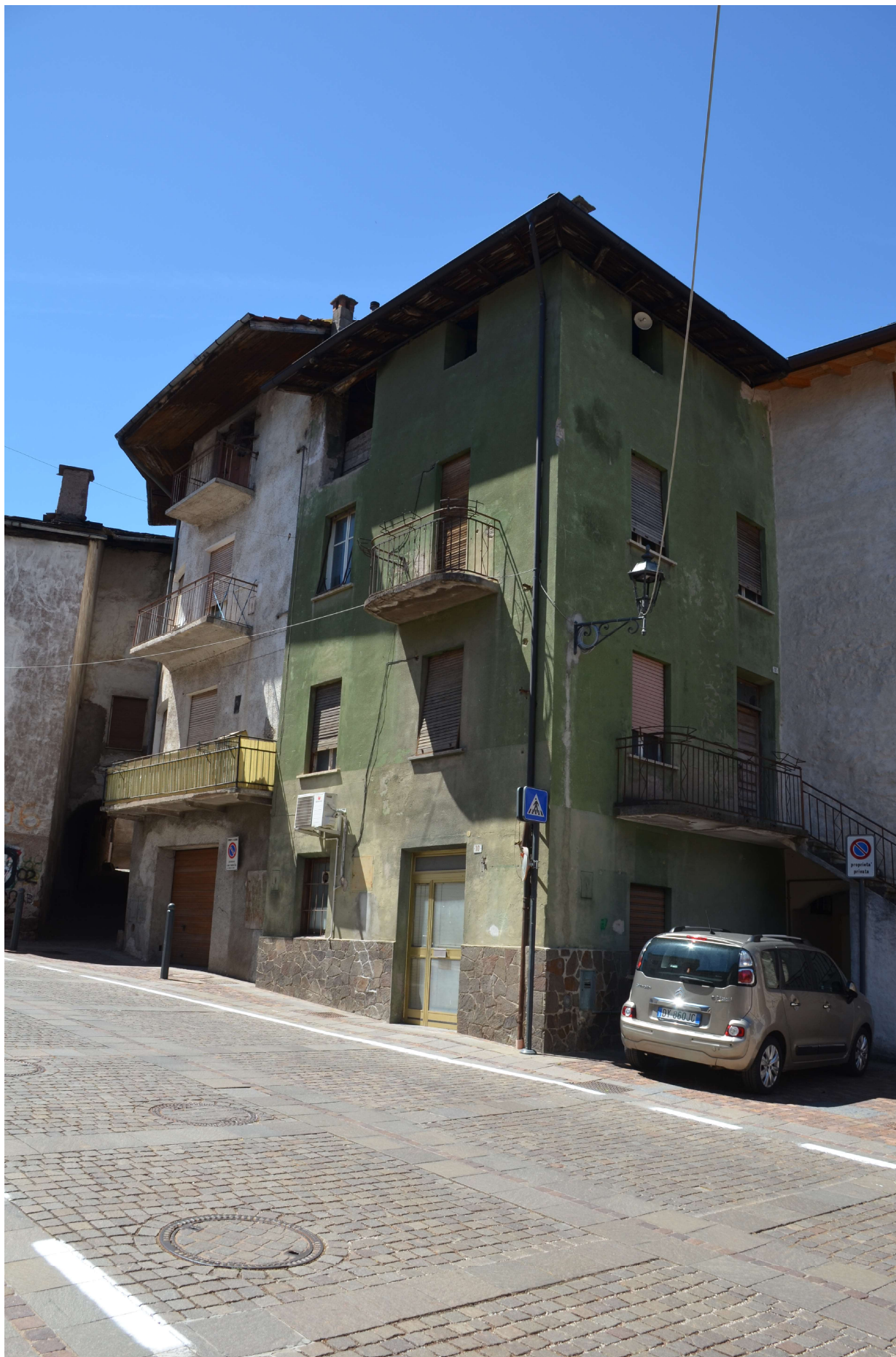
SCORCIO NORD - EST LATO PIAZZA
