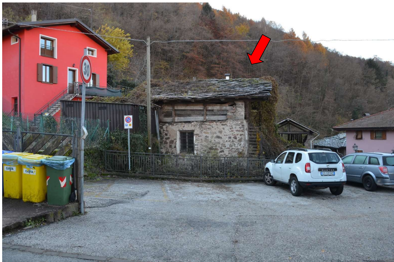
VISTA DA NORD (CON IL PARCHEGGIO OGGETTO DI AMPLIAMENTO)
