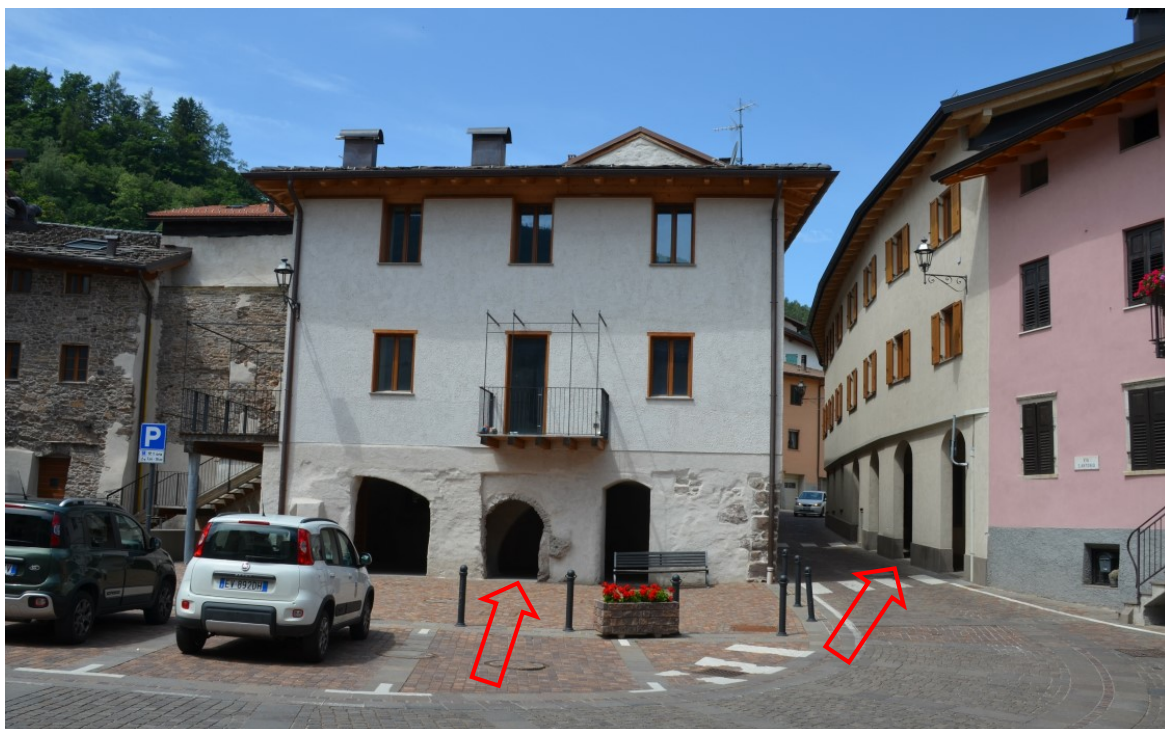
PORTICATI ESISTENTI AI PIANI TERRA DELLE U.E. 45 E 173
