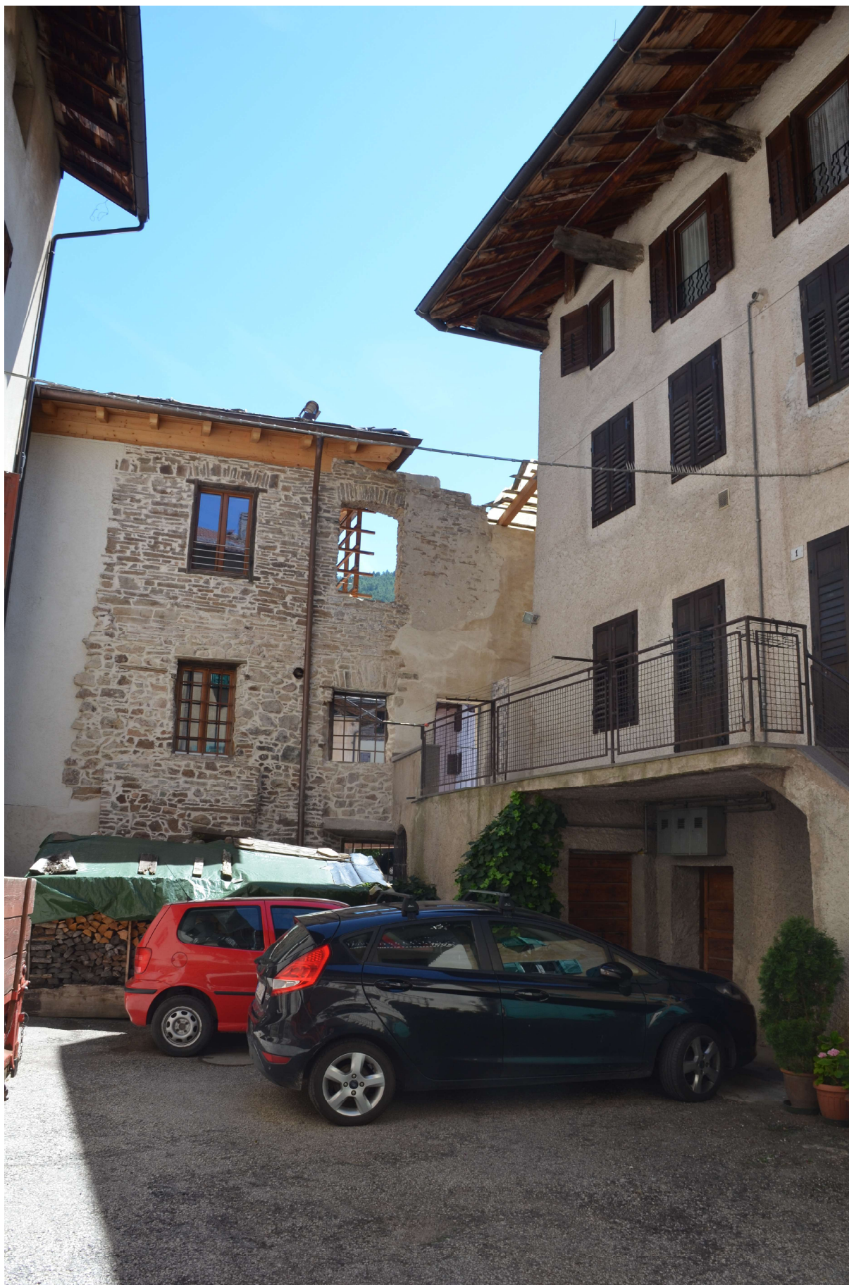
SCORCIO INTERNO CORTILE ANGOLO NORD EST
