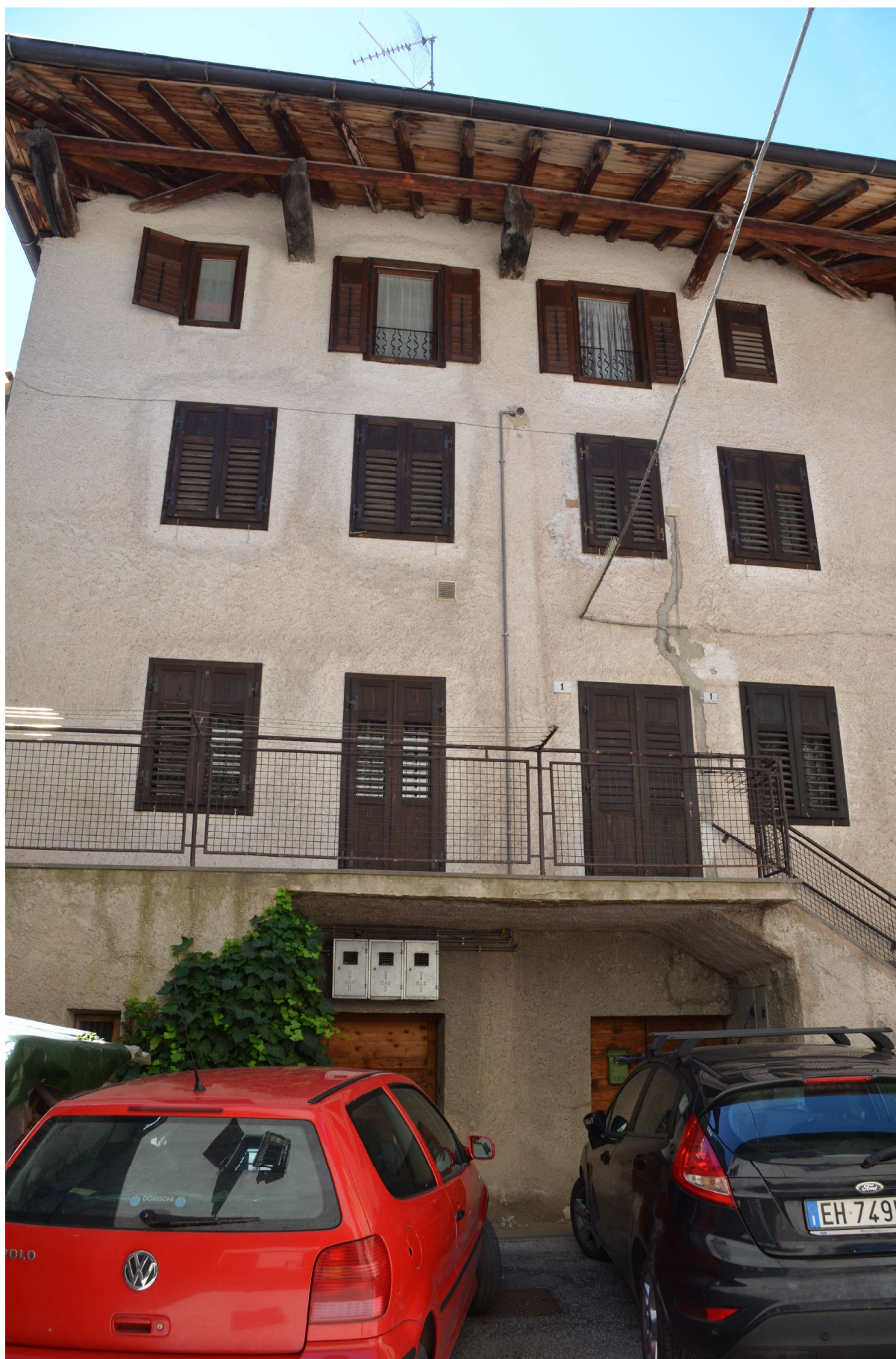
SCORCIO INTERNO CORTILE LATO NORD
